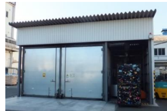
溶融固化施設
