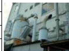
＜騒音対策の例＞ 集塵機及び大型クリーナーの排気口に消音器を設置
